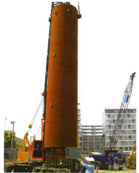
写真-4 KCTB 杭施工状況
