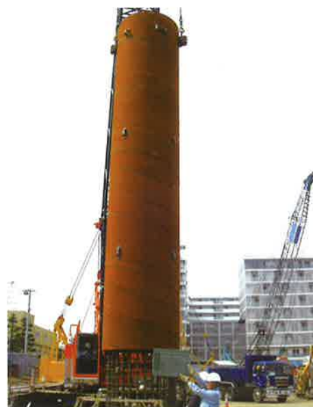
写真-1 KCTB 杭施工状況
