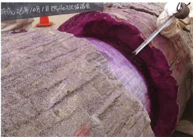
かぶり厚さ測定およびセメント含有状況の確認
