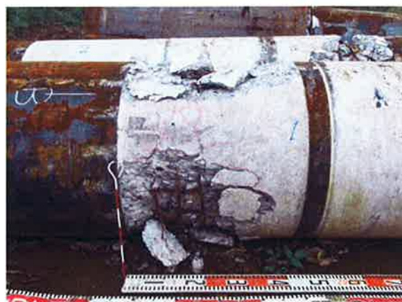
曲げ試験(試験後状況)
